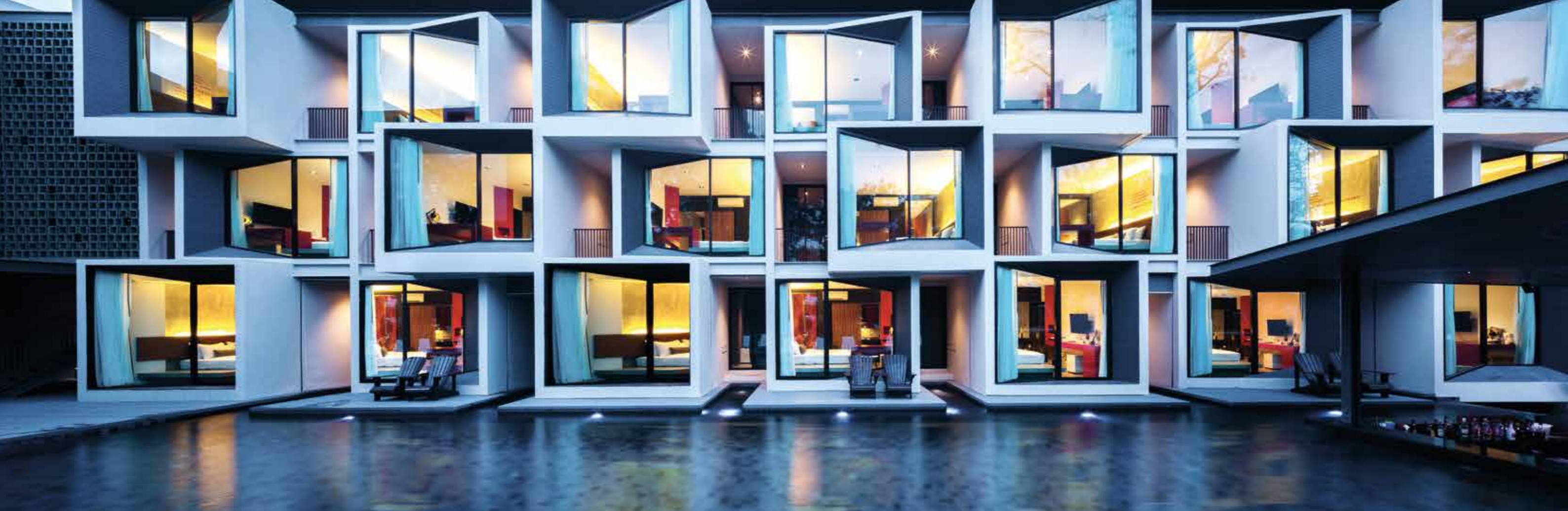
Il fronte interno che dà sulla piscina, con le stanze dotate di balcone coperto che funge da divisore dall'unità adiacente per massimizzare la privacy
